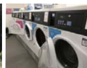
ランドリーの設備
