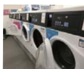
ランドリーの設備
