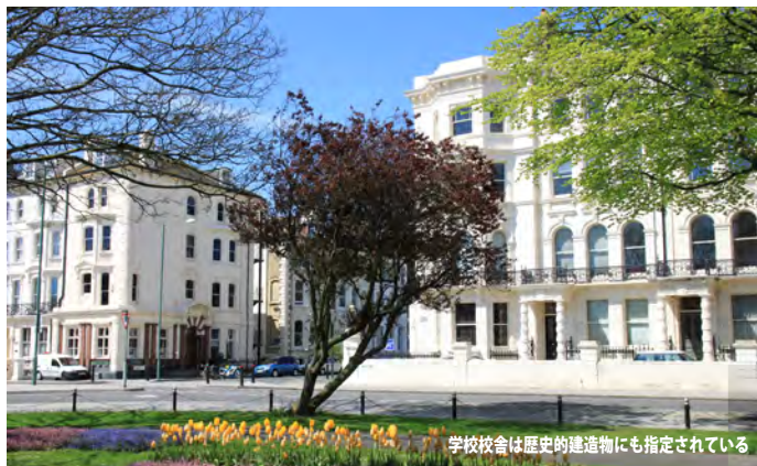
学校校舎は歴史的建造物にも指定されている
